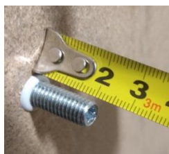
1: Einsetzen der Dübel und
